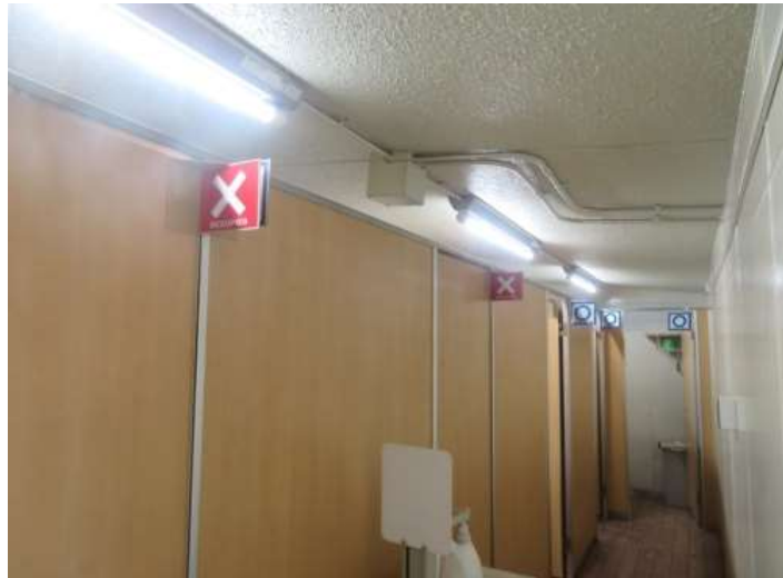
設置後。空き状況が分かりやすくなり、行列解消の一助となったかな。
