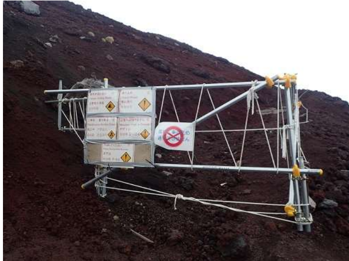
八合五勺通行止め箇所
