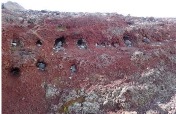
岸壁に詰められた石
